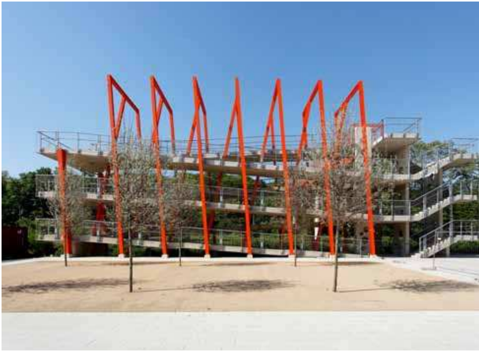
Belvederebrücke, Reinhard Angelis Architekt BDA, Köln
