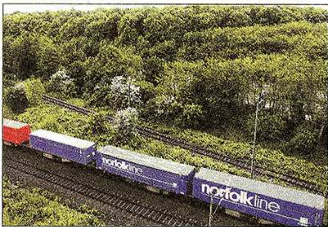
Bahngleise und Militärring trennen Müngersdorf und Vogelsang. Hier soll die neue Brücke gebaut werden. (Foto: Hanano)
