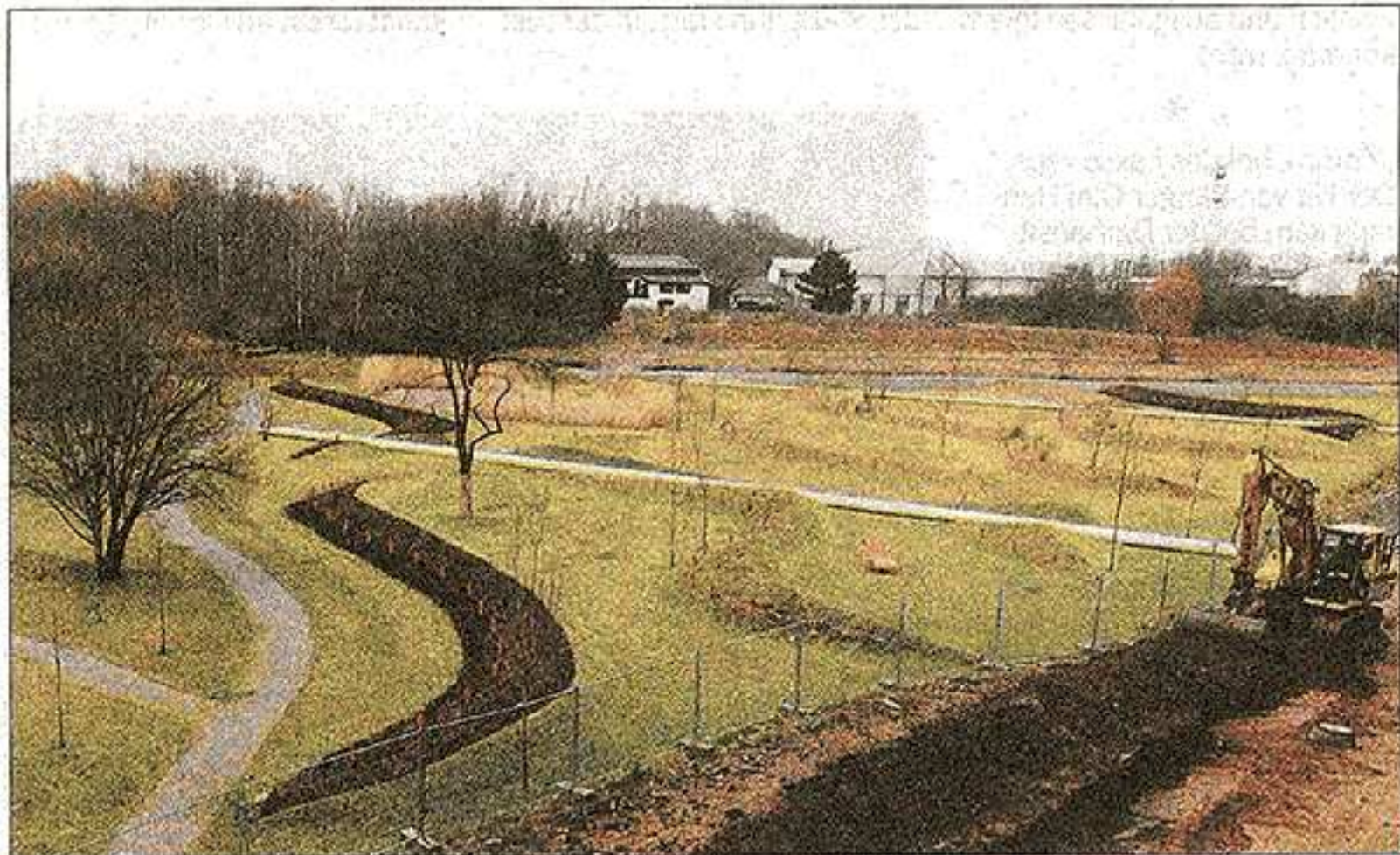
Weit gediehen sind die Arbeiten am künftigen „Wassermannpark“. (Foto: Gauger)
